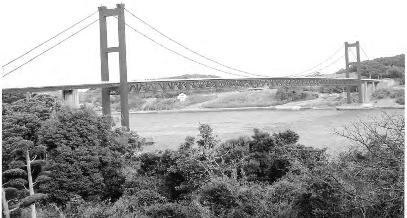
平戸大橋 旧平戸市と旧田平町を結ぶ橋長880mのトラス吊橋構造
