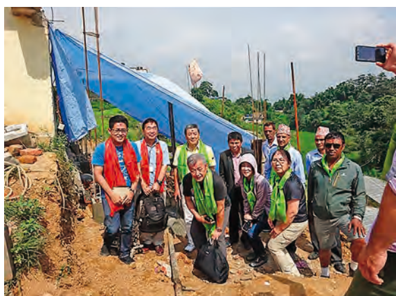
地震で倒壊したトイレの改修工事
